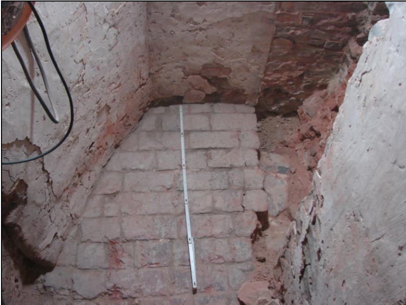
Het bakstenen vloertje beneden de trap in de dikte van de muur.
