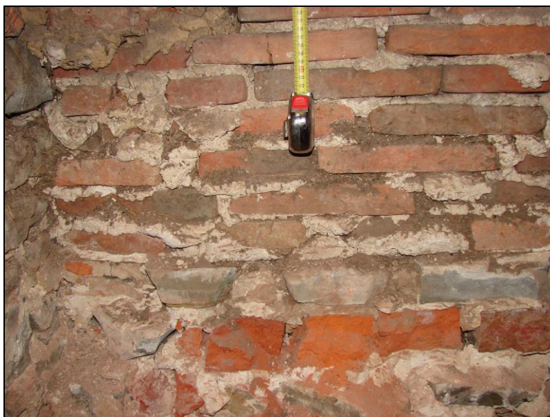
Vulling van de vensteropening met platte bakstenen en duidelijk zichtbare mortelbaarden. Bemerk ook de rij veldstenen met eronder een ander type bakstenen.
