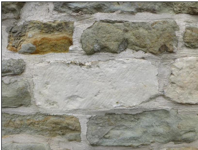
Detailfoto van veldsteen, gekapt in blokken, ter vergelijking rond een witsteen.
