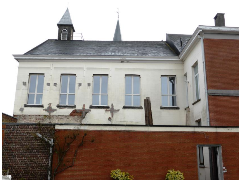
De achterbouw waar de renovatie plaatsgrijpt.
