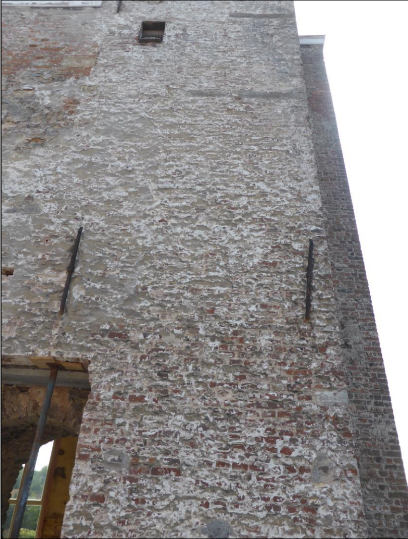
Het noordelijke uiteinde van de westmuur met de ingrijpende aanpassingen in baksteen.
