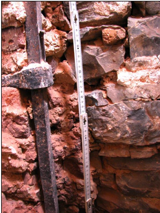
Het anker ingewerkt in de linker deurstijl.
