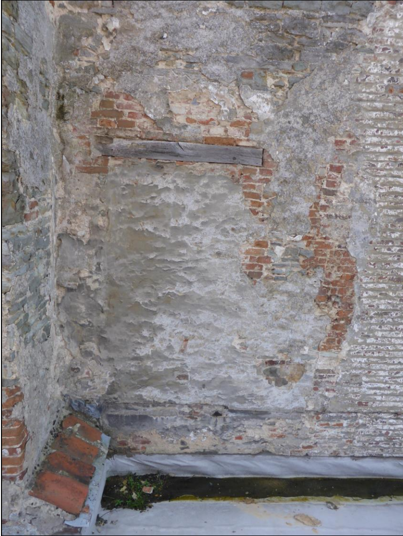
De gedichte toegang tot de eerste verdieping van de vroegere binnenkant bekeken.
