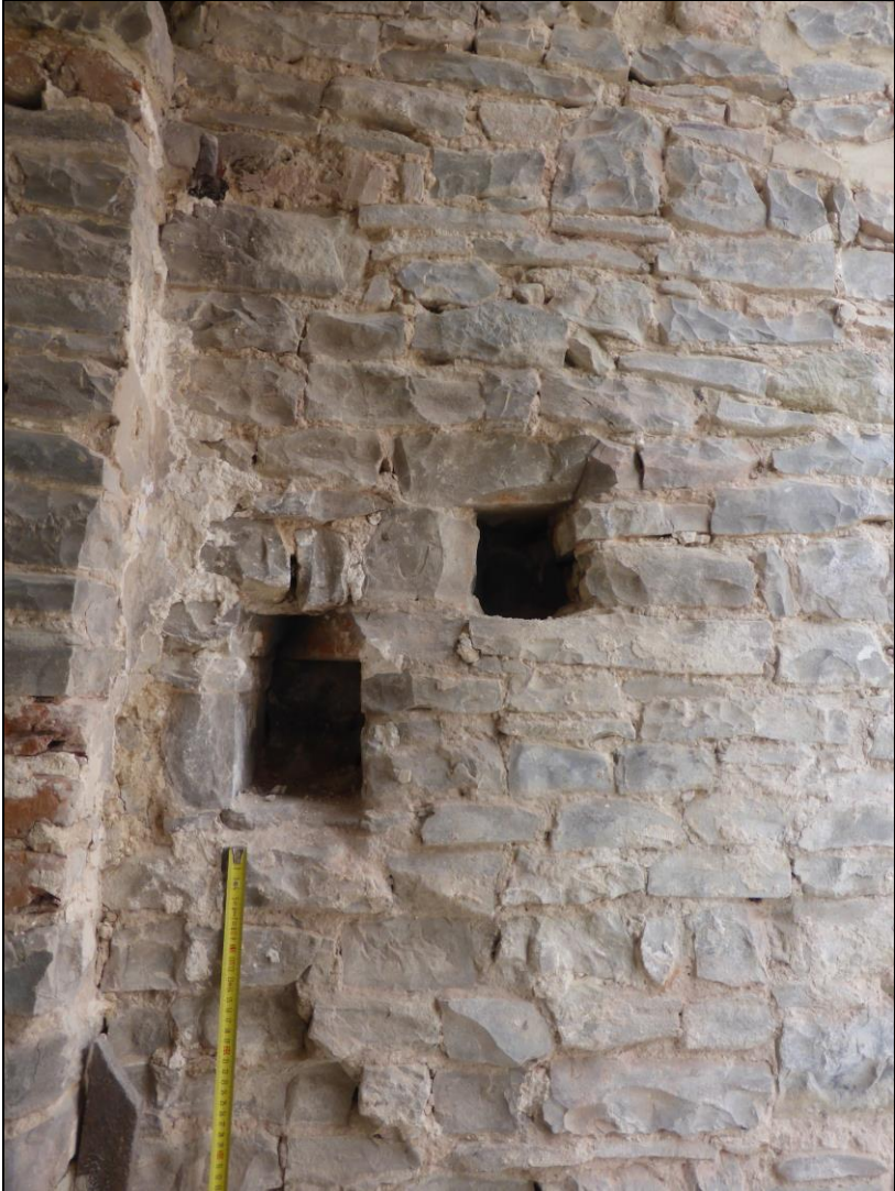
Het sluitbalkgat aan de linkerszijde (noordkant).
