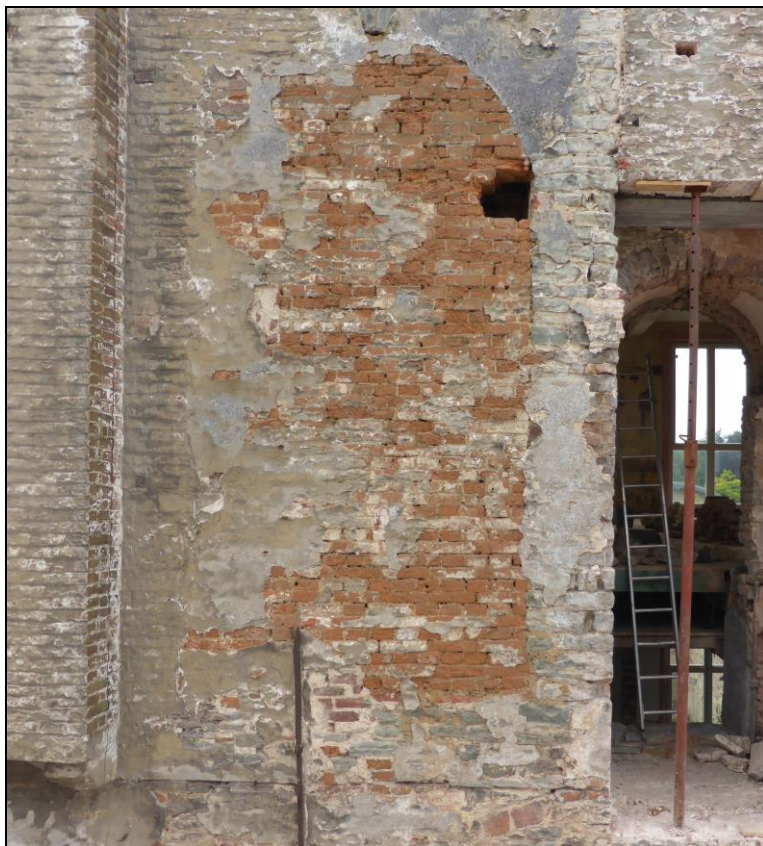
De grote nis, gedicht met rode baksteen (vroegere binnenkant, nu buiten).
