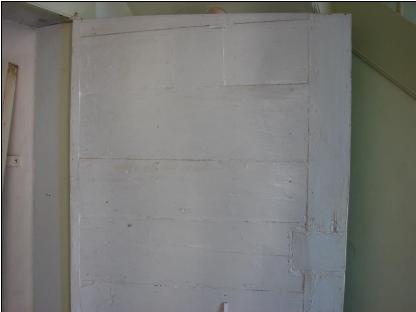
De bovenkant van de zware deur aan de binnenzijde bekeken.
