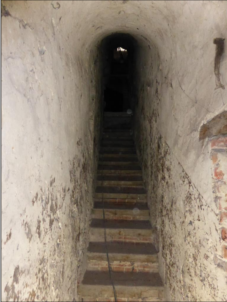
De trap in de dikte van de muur van beneden naar boven toe, met rechts de toegang naar de eerste verdieping nog net zichtbaar.
