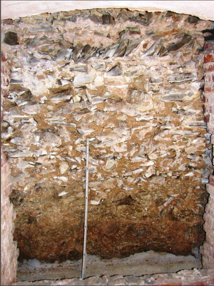
De funderingen van de donjon gezien vanuit de aanpalende kelder. Bemerk hoe de kleur varieert van bleek bovenaan (bindmiddel kalkmortel) naar bruin onderaan (bindmiddel leem).
