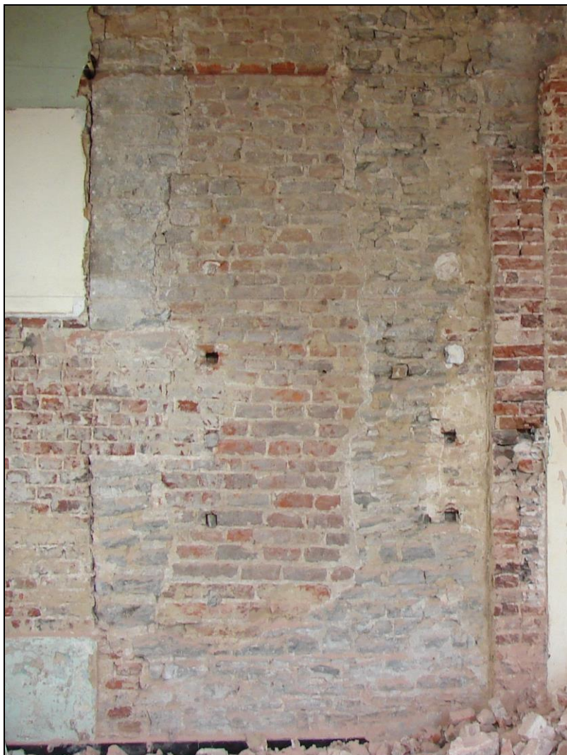
Verbouwingen en herstellingen aan de linkerhoek van de donjon die mogelijk een negatief spoor zijn van een weggebroken weergang.
